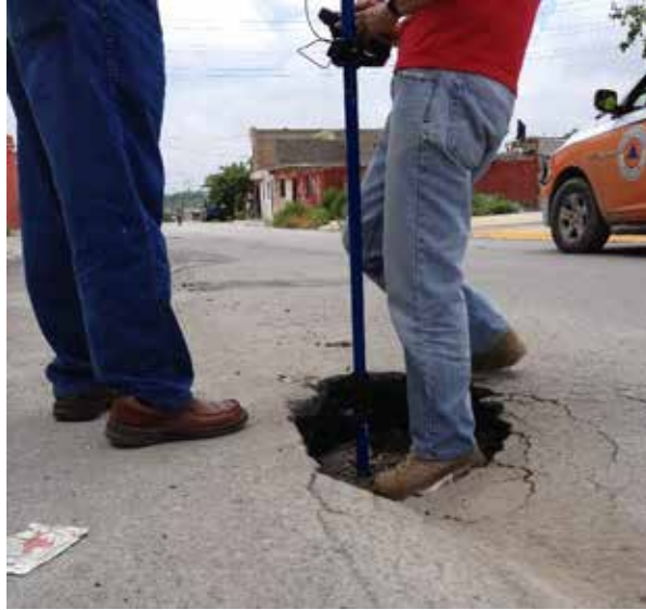
Figura 89. Hundimiento documentado durante las visitas a campo.
