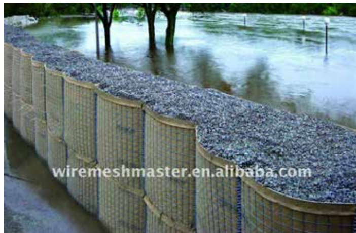
Figura 372. Ejemplos de barreras construidas para protección contra inundaciones.
