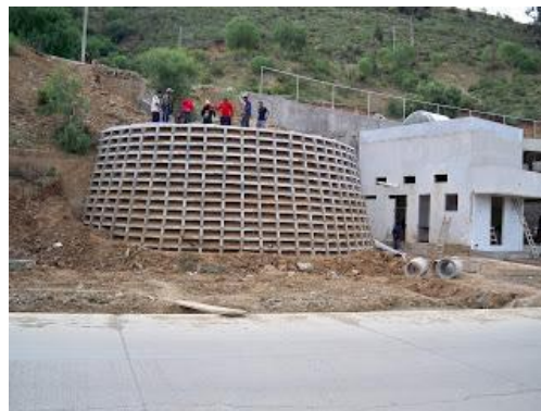
Figura 384. Muros criba para protección de taludes.
