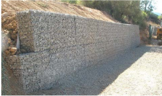
Figura 385. Muros gaviones para protección de taludes.
