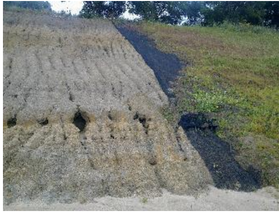
Figura 382. Efecto de la vegetación protegiendo taludes contra la erosión.
