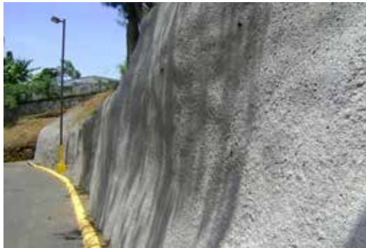
Figura 380. Ejemplo de concreto lanzado en taludes.
