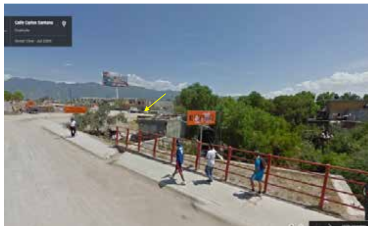
Figura 216. Vista de calle del final del pluvial de Av. Presidente Cárdenas. La flecha amarilla indica la el tubo perteneciente al final del pluvial.
